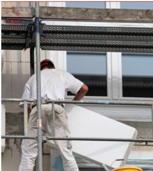
Ärger bei Dachdeckern und Baufirmen in Köln, denn Dämmstoffe aus Styropor gelten jetzt als „gefährlicher Abfall“ und können nur noch in wenigen Müllverbrennungsanlagen entsorgt werden. (Foto: UBA)
